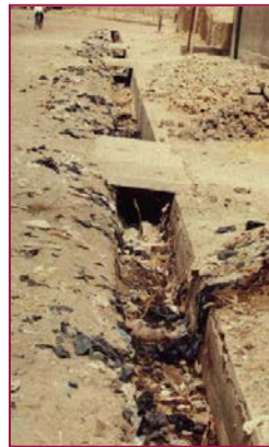
Trop-pleins des latrines traditionnelles se déversant dans la rue
