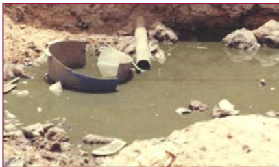
Trop-pleins des latrines traditionnelles se déversant dans la rue
